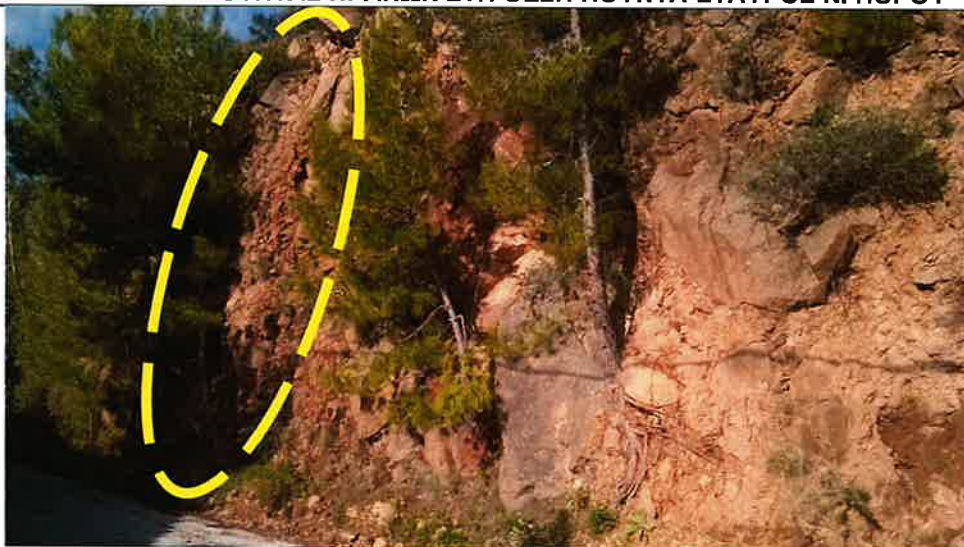
Φωτογραφία 2. Άποψη από την επικινδυνότητα των οριακά σε ισορροπία τεμαχίων του πρανούς
